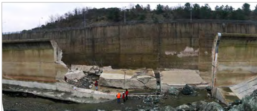
Figura 54. Immagine del dissesto sull'impianto di Montedoglio. L'immagine è ripresa dal coronamento della diga, con il livello di invaso sensibilmente abbassato. Al centro dell'immagine i tre conci del muro dello sfioratore ribaltati sotto l'azione della pressione idrostatica durante il collaudo dell'opera.
