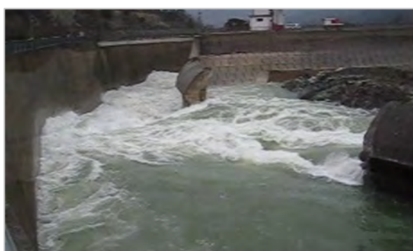
Figura 53. Crollo del muro dello scarico di superficie della diga di Montedoglio sul fiume Tevere e contestuale svuotamento del lago verso il canale fagatore (a sinistra, l'immagine è ripresa diverse ore dopo il collasso). A destra l'idrogramma di piena registrato a Gorgabuia, qualche km a valle della diga. L'evento è del 29 dicembre 2010.
