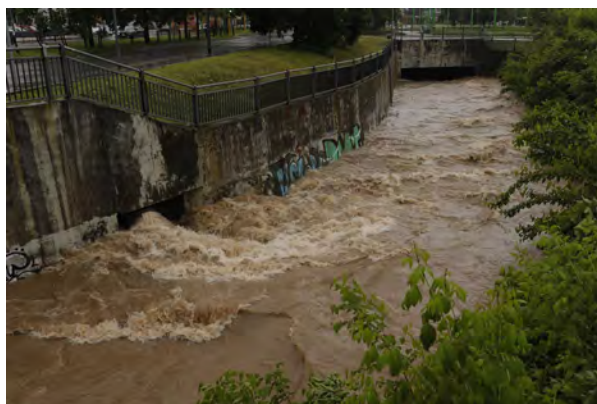
Figura 40. L'imbocco della tombinatura del Seveso a Via Ornato, nel quartiere Niguarda in condizioni di tempo asciutto e durante l'evento del 15 maggio 2023. Si osservi l'imponente contributo del bypass dell'impianto di trattamento di Bresso in sponda sinistra.
