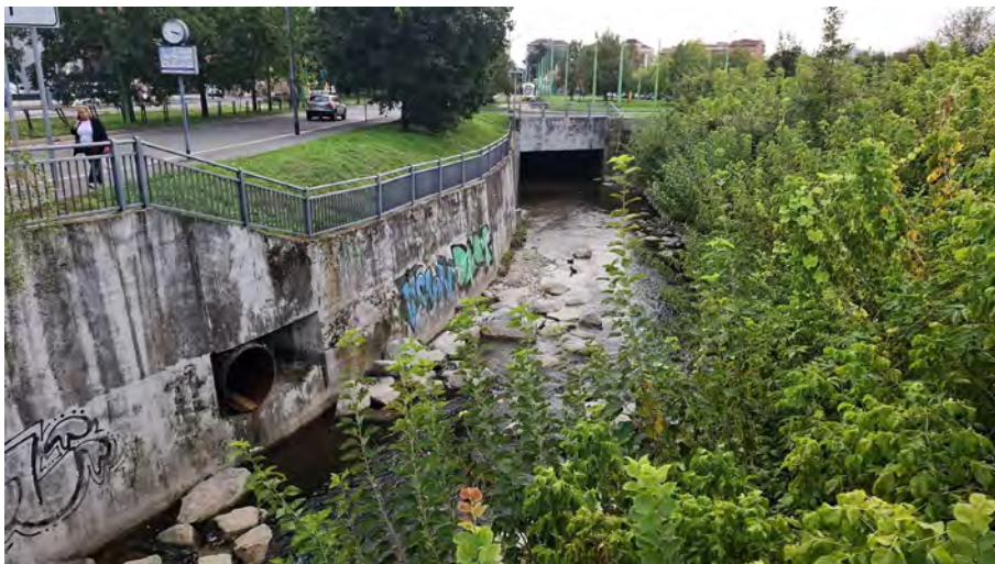
Figura 55. L'imbocco del tombino del Seveso a Via Ornato. L'imponente manufatto di scarico in sinistra idrografica (in primo piano nella fotografia) è sbocca il bypass dell'impianto di depurazione di Bresso
