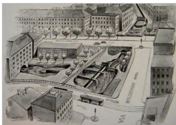
Figura 59. Ancora uno schema del "manufatto partitore" del Redefossi all'intersezione tra Via Melchiorre Gioia e i Bastioni di Porta nuova in una stampa del secolo scorso (a sinistra) e nell'immagine Google (a destra). Si nota il Naviglio che procede lungo Via San Marco (adesso non più funzionante).
