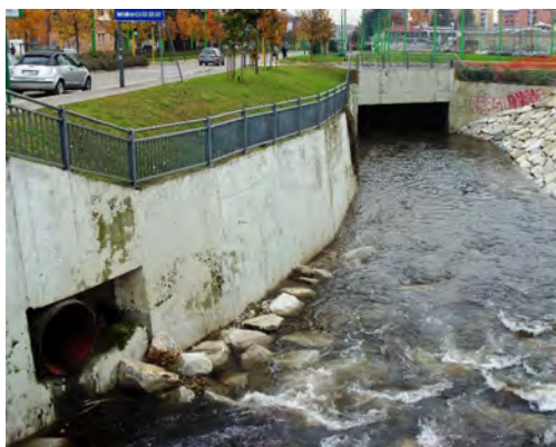
Figura 40. L'imbocco della tombinatura del Seveso a Via Ornato, nel quartiere Niguarda in condizioni di tempo asciutto e durante l'evento del 15 maggio 2023. Si osservi l'imponente contributo del bypass dell'impianto di trattamento di Bresso in sponda sinistra.
