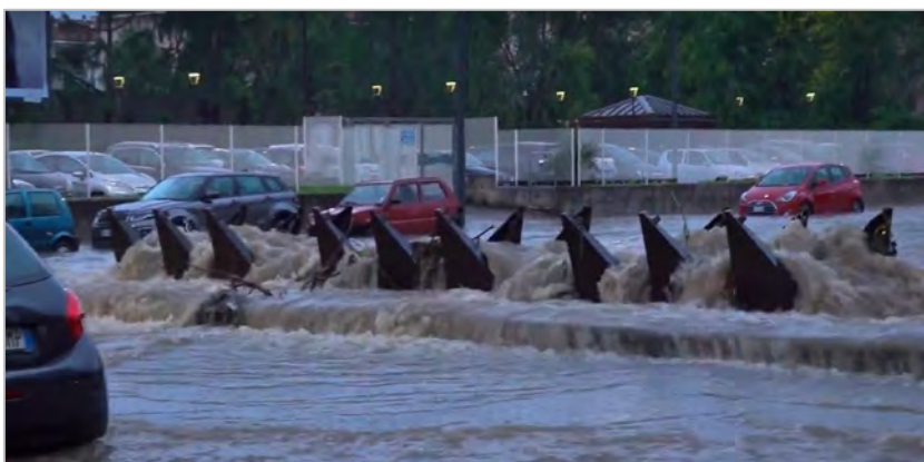
Figura 42. I chiusini di ispezione del tombino del Seveso in Via Valfurva si aprono per la pressione dell'acqua sul cielo della volta, provocandone l'apertura e il deflusso sul piano stradale.
