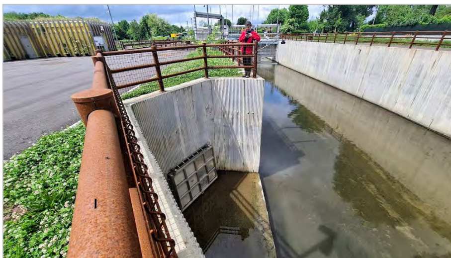
Figura 53. Opera di restituzione per lo svuotamento della vasca. In alto a sinistra la stazione di pompaggio, al centro dell'immagine la paratoia a clapet.
