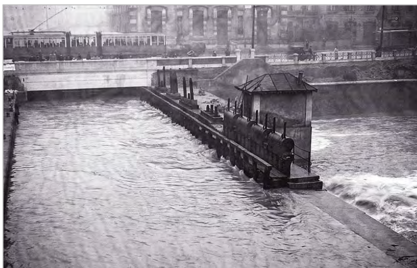
Figura 35. Immagine storica del manufatto partitore della Martesana agli inizi del '900. Si osservano i martinetti di manovra delle quattro paratoie, il locale di controllo e, nella parte in basso a destra dell'immagine, la soglia libera, funzionante anche in caso di criticità sul sistema delle paratoie mobili.
