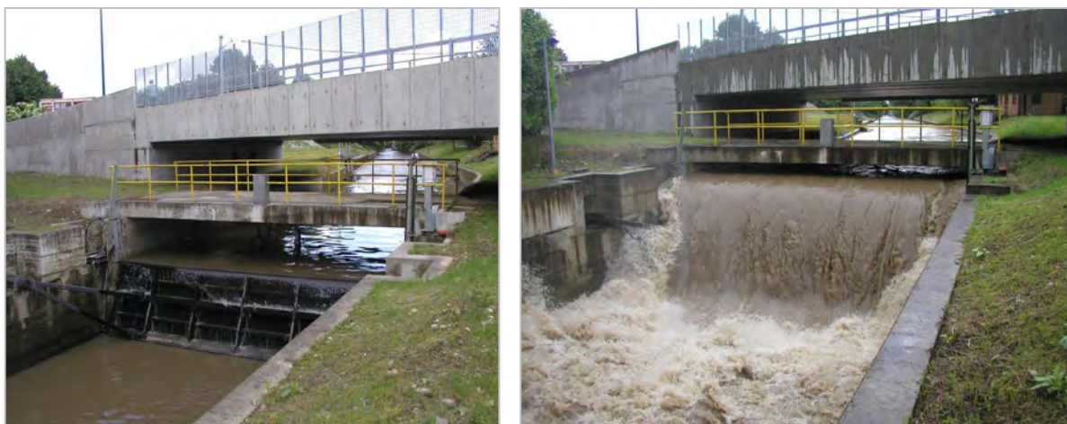
Figura 50. La paratoia a settore sul Seveso a Palazzolo, in procinto di essere tracimata (a sinistra) e in piena tracimazione (a destra)
