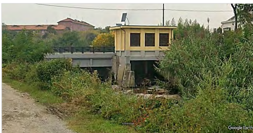
Figura 28. Il ponte-canale con il quale il Molgora sottopassa il Naviglio della Martesana. Si nota il manufatto che controlla il rilascio delle portate dal Naviglio verso il fiume (Immagine Google).
