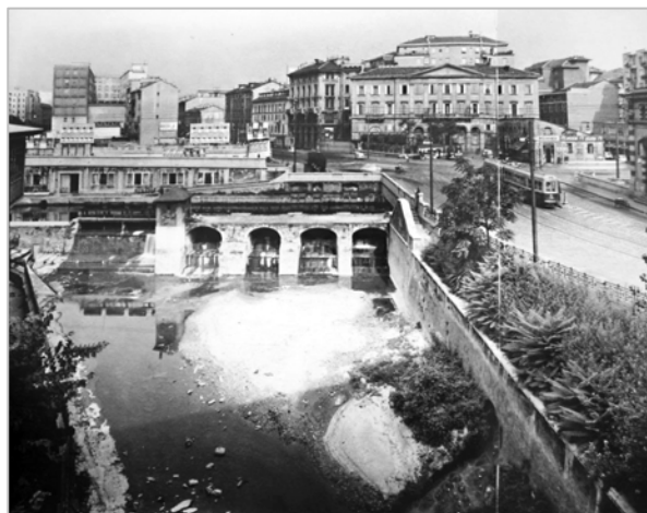
Figura 57. Il Manufatto partitore della Martesana al Ponte delle Gabelle, dal quale origina il Cavo Redefossi in una immagine antecedente la copertura avvenuta tra il 1950 e il 1960. A destra, la stessa zona oggi, con il Cavo coperto e l'intersezione tra Via Melchiorre Gioia e Viale Montegrappa (Immagine Google).
