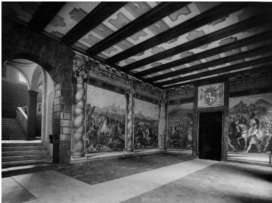
1940 Sala Affreschi dopo il restauro e prima della ristrutturazione post bellica
