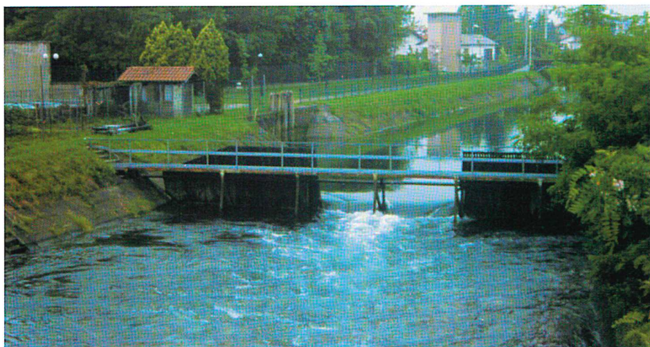
Paratoie di regolazione del livello dell'acqua
