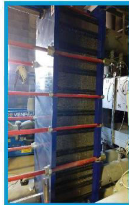
Scambiatore di Calore - vista laterale piastre -
