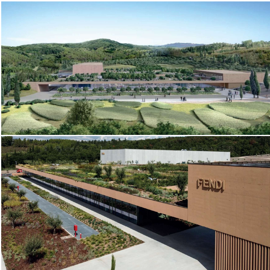
Polo industriale e logistico Fendi, Bagno a Ripoli (FI)
