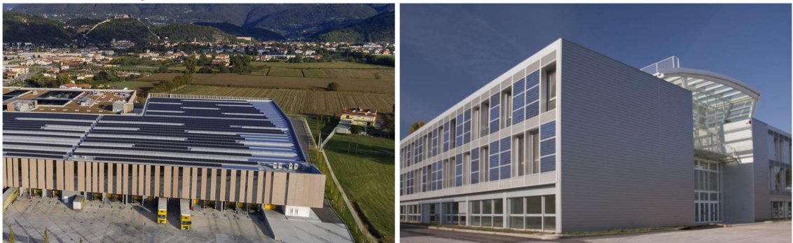
Facciata fotovoltaica, polo tecnologico di Lucca, IT e Pannelli solari sul nuovo Polo Logistico di Vimar a Marostica, IT
