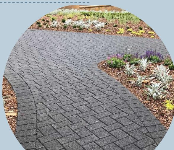
Sostituzione della pavimentazione esistente con pavimentazione permeabile, realizzazione di box alverati e pozzi di infiltrazione per permettere la disconnessione dalla rete fognaria
