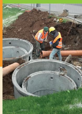
Messa in opera del sistema di rimozione olii. Implementation of the oil removal system.
