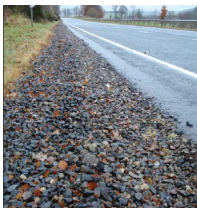
Figura 32. Sinistra: esempio di trincea infiltrante. Ballard et al., 2015 Destra: Tipologico trincea infiltrante. Comune di Bologna, 2018
