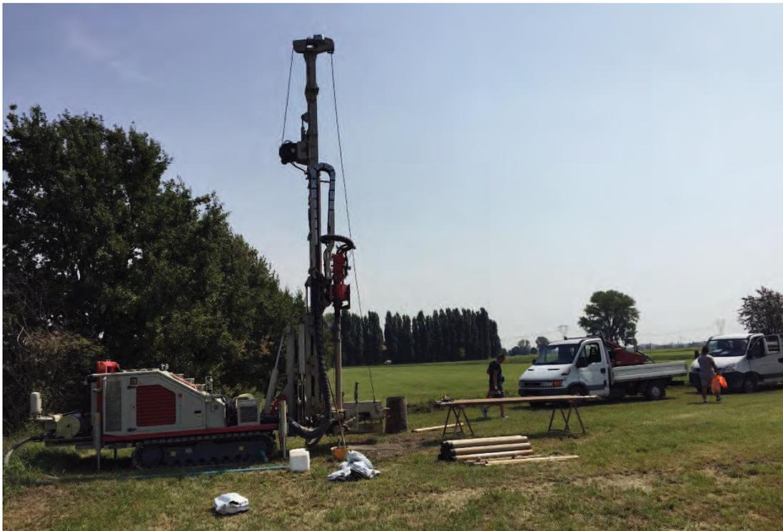
Figura 1 – Piazzamenti della perforatrice ComacchioGEO601 (punto S1)
